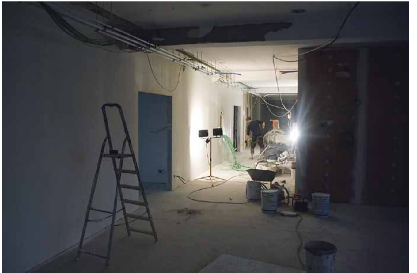
Antsla gümnaasiumi renoveerimisega paigaldatakse kõigisse ruumidesse ventilatsioon. Ventilatsioonist tunnevad puudu ka ehitustolmu sees viibivad töölised. Foto on tehtud Antsla gümnaasiumi kolmanda korruse koridoris 24. jaanuaril 2024. Fotod: Kalle Nurk
